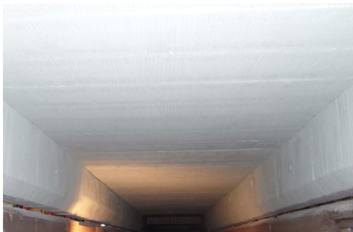
EJEMPLO DE RENOVACION EN PAREDES Y TECHO EN ZONA DE COCCION
